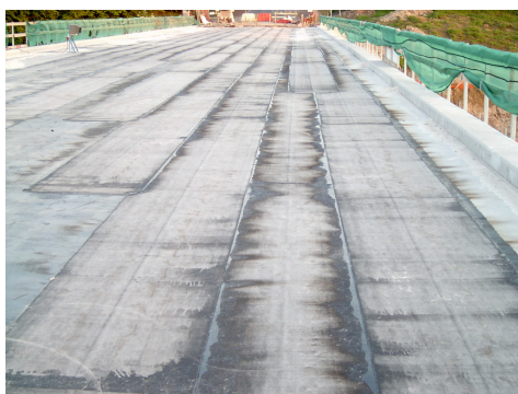
Figure 9 : feuilles préfabriquées posées par soudure au chalumeau.
