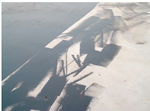
Figure 8 : Vernis d'adhérence posé au rouleau.
