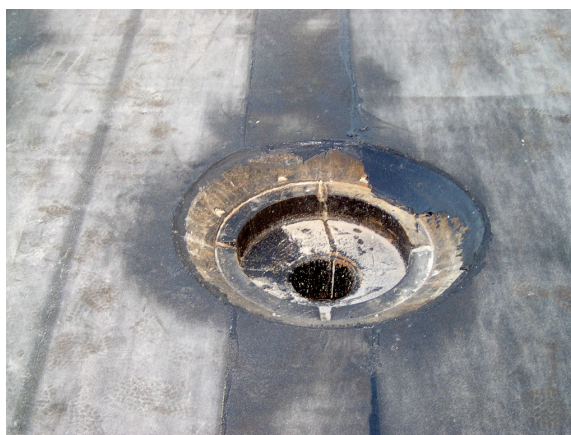
Figure 7 : Avaloirs entourés par l'étanchéité en feuilles préfabriquées.
